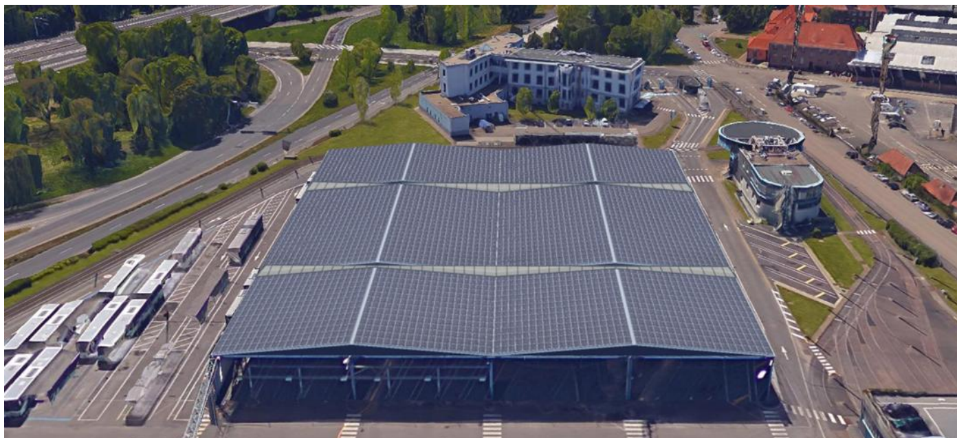
En juin 2019, des panneaux photovoltaïques auront remplacé les «tentes en bout de course». DOCUMENTS REMIS
